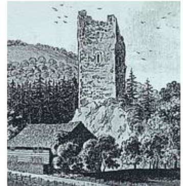
Burgruine mit dem Turm Mitte des 18. Jahrhunderts. Foto RZ
